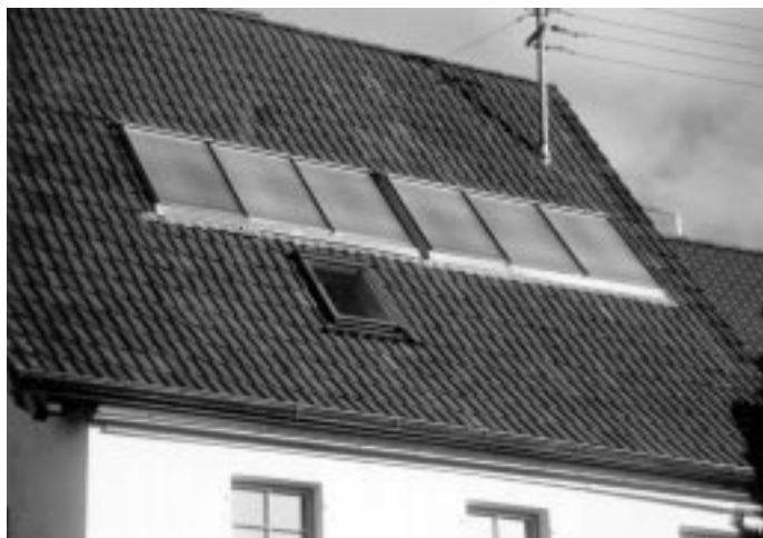
Solaranlagen zur Warmwasserbereitung lassen sich gut ins Dach integrieren.
