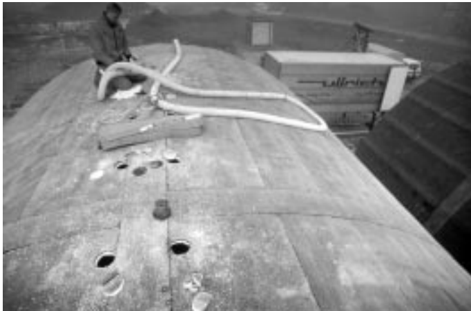
Zellulosedämmung wird zwischen Holzverschalungen eingeblasen. Bild: E. Kern
