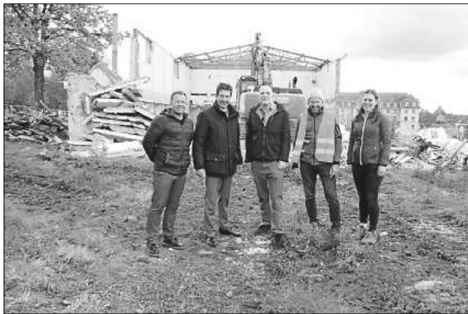
(v. l.) Elias Thoma (Konversions- und Entwicklungsgesellschaft mbH), Oberbürgermeister Erik Pauly, Christian Unkel (Geschäftsführer der Konversions- und Entwicklungsgesellschaft mbH), Michael Messner (Geiger Abbruch GmbH) und Denise Honer (Breinlinger Ingenieure) auf dem Gelände des Cinéma. Im Hintergrund arbeitet der Abrissbagger.
